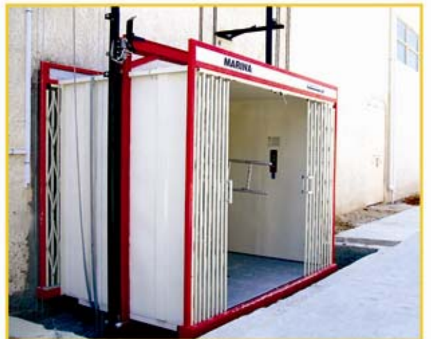
يعمل بنظام لف الوير. Wires lifting system.
