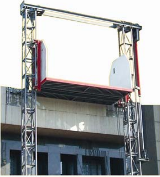
مصعد ذو مساحة كبيرة لنقل البضائع. Large hydraulic lift mast type to lift goods.
