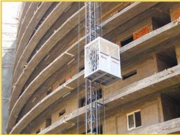
مصعد تشوينات يمكن فكّه و تركيبه و نقله من موقع لأخر. Can be transferred from one place to another.
